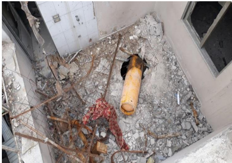
图片 28：2 号地点屋顶地板上的气瓶
