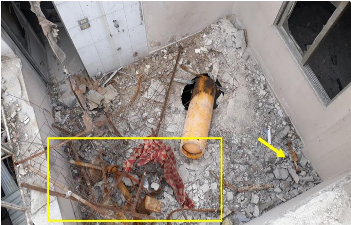
图片 14：2 号地点气瓶旁可见到已脱开的托架(来源：事实调查组)
