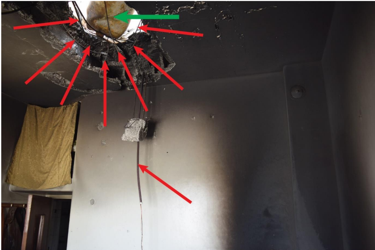
图片 37: 2 号地点混凝土中钢筋相对建筑物朝里的可见变形
