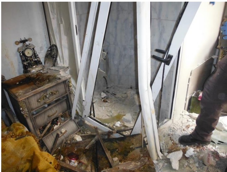
图片 50： 损坏的淋浴装置的图片。损坏可能是由部分气瓶组装体造成的 (来源：事实调查组)
