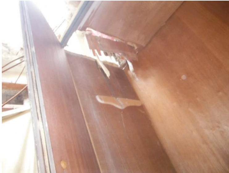
图片 50： 损坏的淋浴装置的图片。损坏可能是由部分气瓶组装体造成的 (来源：事实调查组)
