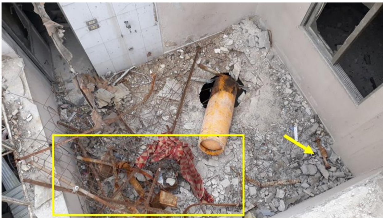
РИСУНОК 14. ОТОРВАННАЯ ЛЮЛЬКА ВИДНА РЯДОМ С БАЛЛОНОМ В МЕСТЕ 2 (ИСТОЧНИК: МУФ)
