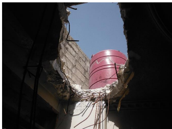
РИСУНОК 33. ПРОБОИНА В КРЫШЕ В МЕСТЕ 4, ВИДЫ СВЕРХУ И СНИЗУ
