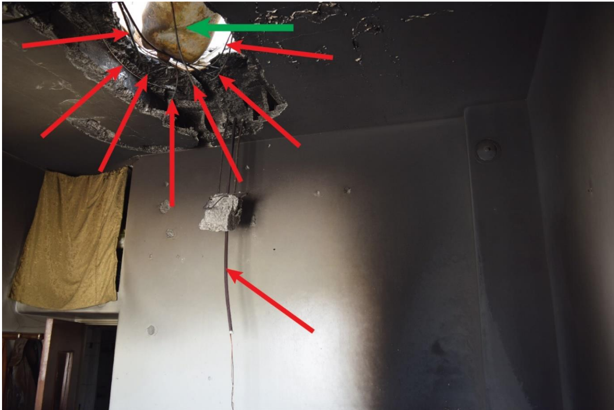
РИСУНОК 37. ВИДИМАЯ ДЕФОРМАЦИЯ СТАЛЬНОЙ АРМАТУРЫ В БЕТОНЕ В НАПРАВЛЕНИИ ВНУТРЕННЕЙ ЧАСТИ ЗДАНИЯ В МЕСТЕ 2
