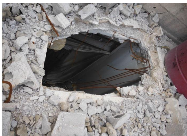
РИСУНОК 33. ПРОБОИНА В КРЫШЕ В МЕСТЕ 4, ВИДЫ СВЕРХУ И СНИЗУ
