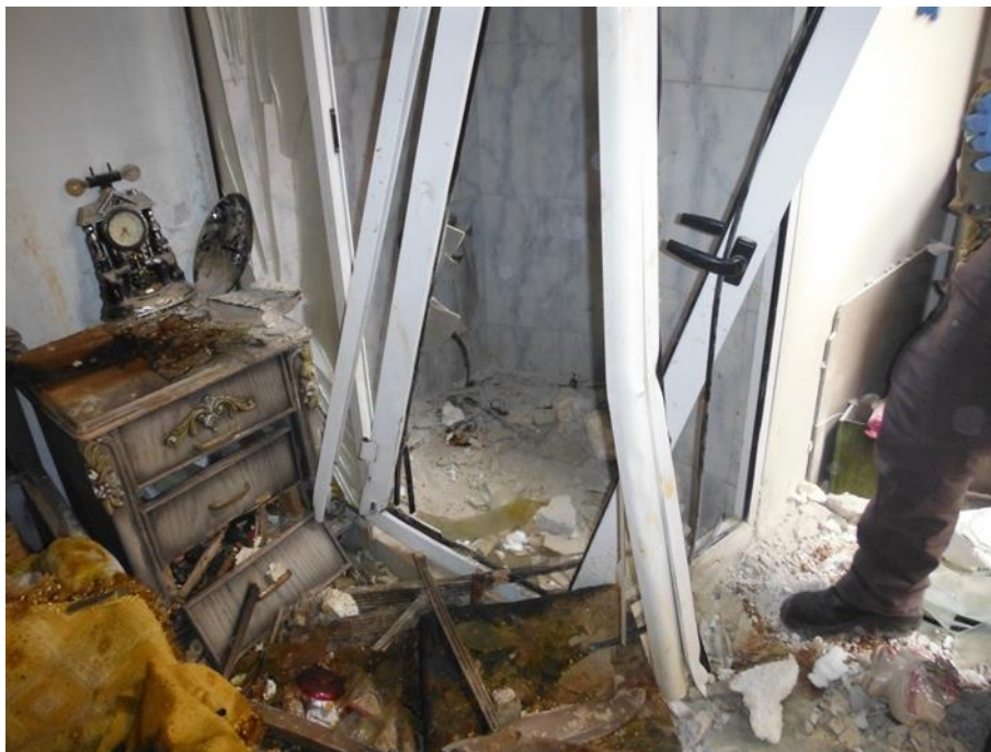
РИСУНОК 50. ФОТОГРАФИЯ ПОВРЕЖДЕННОЙ ДУШЕВОЙ КАБИНЫ. ПОВРЕЖДЕНИЕ, ВЕРОЯТНО, ВЫЗВАНО ЧАСТЯМИ СБОРКИ БАЛЛОНА (ИСТОЧНИК: МУФ)
