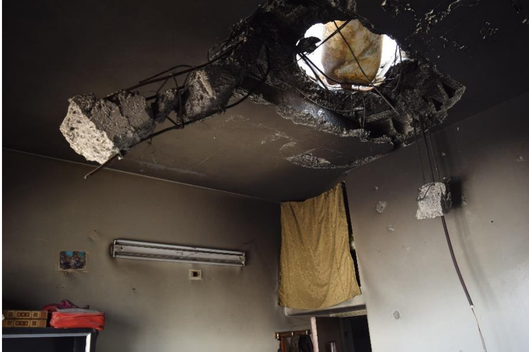
ILLUSTRATION 37 : DÉFORMATION VISIBLE DES BARRES D'ARMATURE EN ACIER DANS LE BÉTON VERS L'INTÉRIEUR DU BÂTIMENT À L'EMPLACEMENT N° 2
