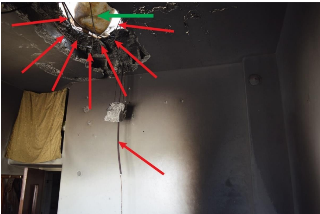
ILLUSTRATION 37 : DÉFORMATION VISIBLE DES BARRES D'ARMATURE EN ACIER DANS LE BÉTON VERS L'INTÉRIEUR DU BÂTIMENT À L'EMPLACEMENT N° 2
