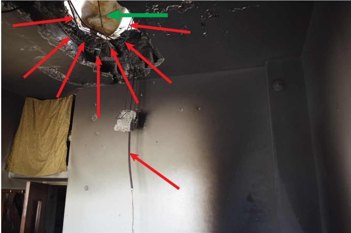
FIGURA 37: DEFORMACIÓN VISIBLE DE LAS VARILLAS DE ACERO EN EL HORMIGÓN HACIA EL INTERIOR DEL EDIFICIO DEL LUGAR 2.
