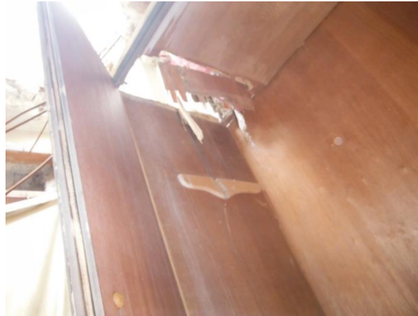
FIGURA 50: IMAGEN DE LA UNIDAD DE DUCHA DAÑADA. LOS DAÑOS SON PROBABLEMENTE CAUSADOS POR PARTES DEL CONJUNTO DE LA BOMBONA (FUENTE: MISIÓN)
