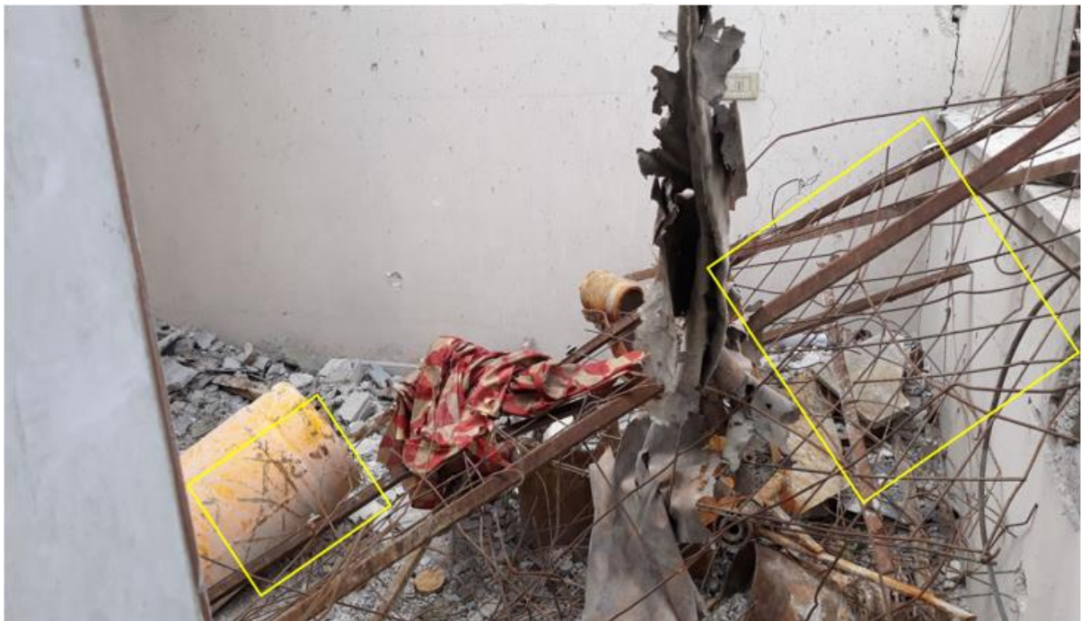
FIGURA 12: DAÑO EN FORMA DE CUADRÍCULA VISIBLE EN EL CUERPO DE LA BOMBONA QUE PARECE CORRESPONDERSE CON EL PATRÓN CUADRICULADO DE LA MALLA METÁLICA SITUADA EN LA AZOTEA. (FUENTE: MISIÓN)
