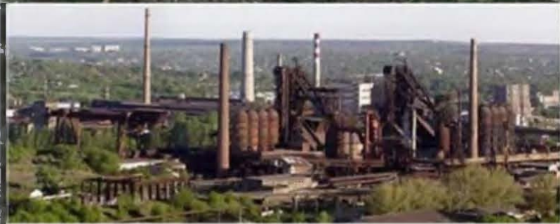
Краматорский металлургический комбинат
